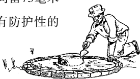
具有保护性的圆柱形护壁成型。
