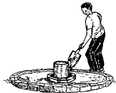
浇筑混凝土井盖，同时浇筑具有保护性的圆柱形井口护壁。
