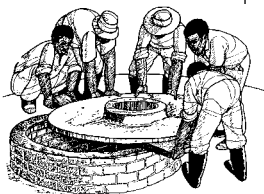
把浇注好的井盖盖上。
