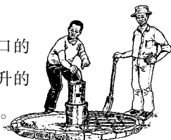
在模型中放入加强型铁丝网和铁皮鼓模型。
