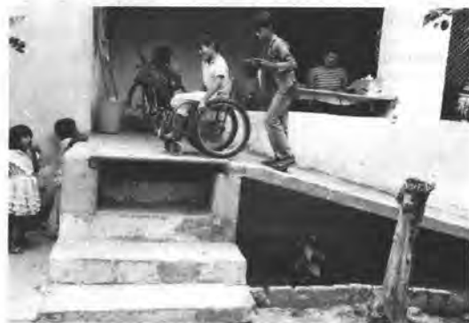
Работники здравоохранения – участники проекта Пьякстла – соорудили этот скат, теперь все передвигающиеся в колясках могут без труда приехать в поликлинику (Фото Джона Феджо).
