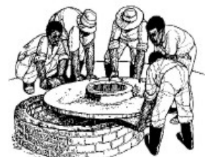
Установите плиту колодца на место
