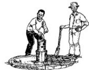
Поместите армированную проволоку и форму для отверстия
